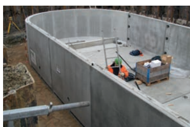
Runde/ovale prefabrikkerte tanker med U-profiler - Ø 5600 mm
