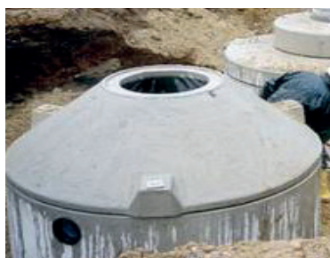
Runde prefabrikkerte tanker
