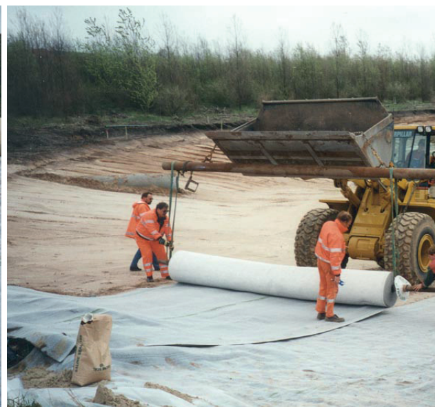
Udlægning af membran
