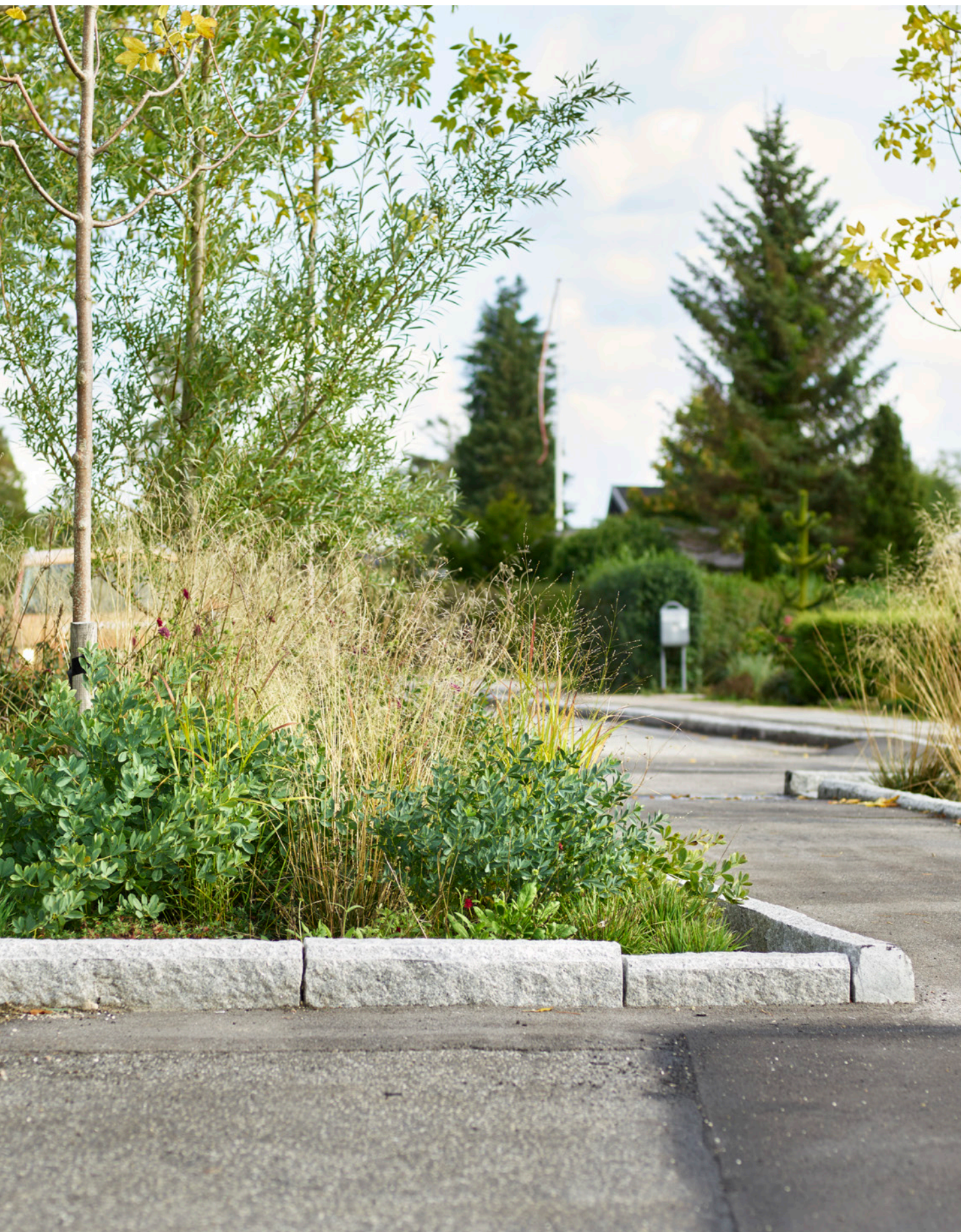
Sænket bedkant for styret overløb.
