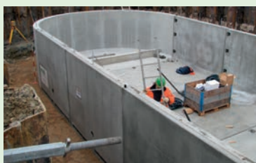
Runde/ovale præfabrikerede tanke med U-profiler - Ø 5600 mm
