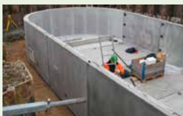
Runde/ovale præfabrikerede tanke med U-profiler - Ø 5600 mm
