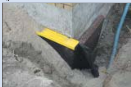
Isodrän-plader beskyttes med fiberdug og kantlister
