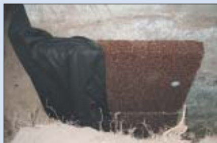
Isodrän-plader beskyttes med fiberdug og kantlister
