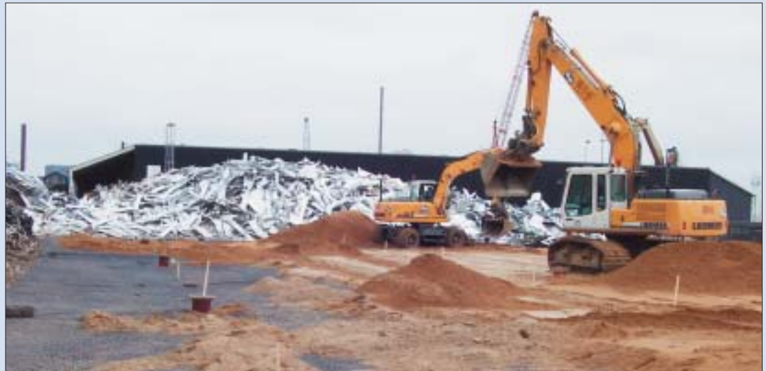
Udlægning af geonet og bundsikring på arealet
