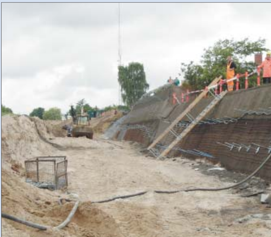
Stejle skråninger sikres med Titan ankre og beton
