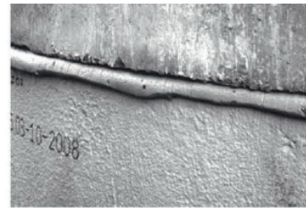
Fig. 20 Udjævn det mørtel der bliver presset ud.
