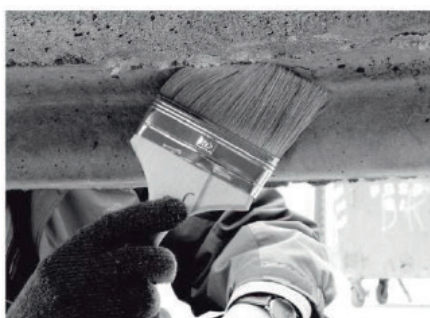
Fig. 10 Rengør bunden af den ring der skal sættes oven på gummipakningen og påfør glidemiddel (DS Gleitmittel).
