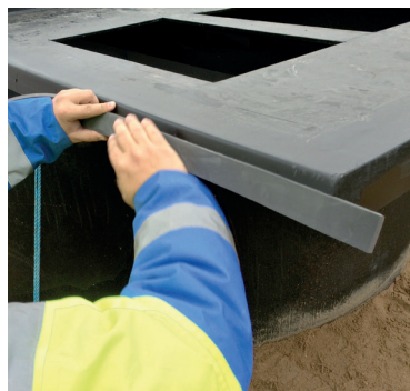
Fig. 23 Montering af fugebånd på skillevægge.
