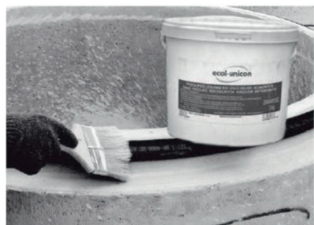
Fig. 12 Påfør glidemiddel (DS Gleitmittel) på pakningen.
