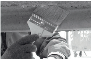
Fig. 18 Rengør bunden af den ring der skal placeres oven på bentonit-pakningen.
