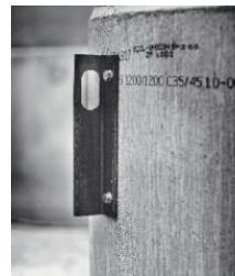
Fig. 8a Specielt løftebeslag: L-profil
