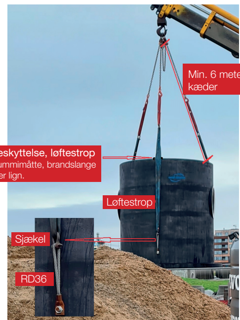
Fig. 8b Specielt løftebeslag: løftesøjle. (Skal returneres til BG Byggros)
