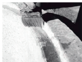
Fig. 15 Rengør grundigt øverste kant på den nederste ring.
