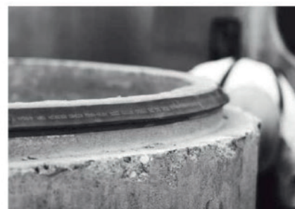
Fig. 11 Gummipakningen placeres på brøndens øverste kant. Pakningen skal hvile på den midterste kant af brøndens spidsende.
