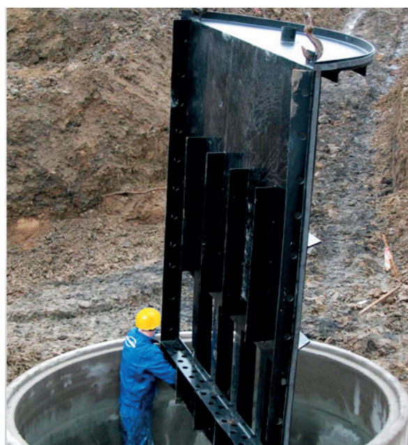
Montering af udløbsskillevæg.
