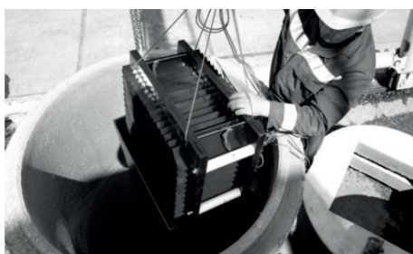
Fig. 31 Op- og nedtagelse af lamelsektioner.
