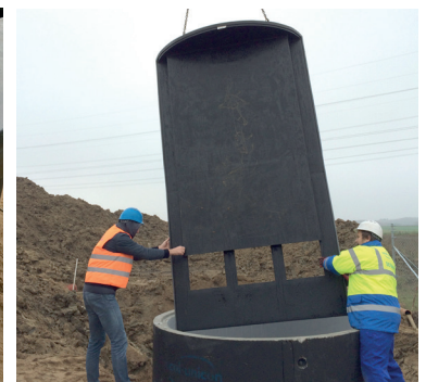
Fig. 24 Placering af skillevægge i udskilleren.
