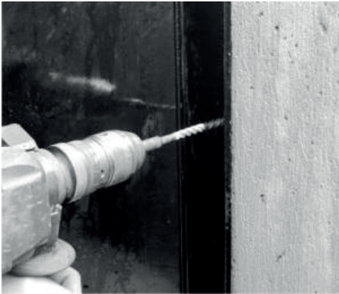
Fig. 28 Forboring af huller til ekspansionsboltene ved fastgørelse af væggene til tanken.
