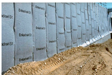
Enkadrain CL anvendt som dræn og vandtætning i forbindelse med etablering af kælder.
