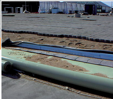
Enkadrain anvendt i forbindelse med parkeringsdæk.
