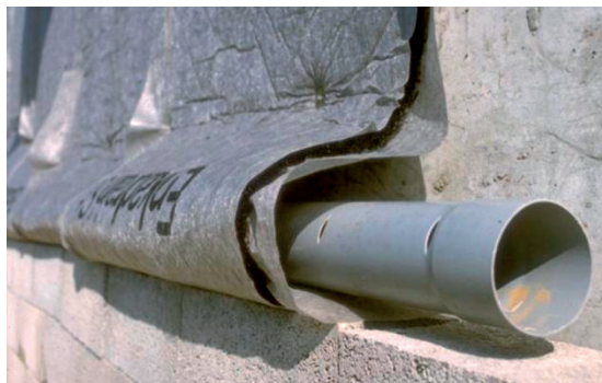
Brug af Enkadrain i forbindelse med kældervæg
