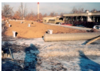
Enkadrain anvendt på taghaver i Hørsholm – rullebredde 5,0 m
