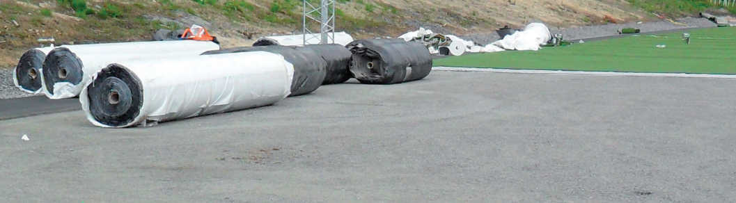
Enkadrain anvendt som gasdræn i deponi.
